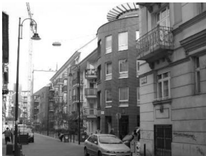
24. ábra Ingatlanfejlesztő vállalkozás által az akció keretében épített új társasház a Berzenczey utcában 21
